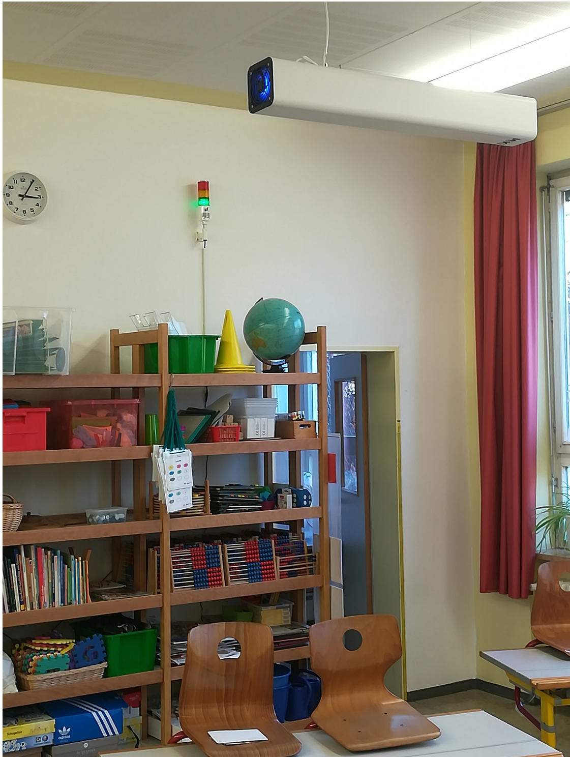
Bild: Fensterlüftung, CO 2 -Ampel und UVC-Ventilator bilden die Grundlage der Raumlufthygiene in Klassenräumen
